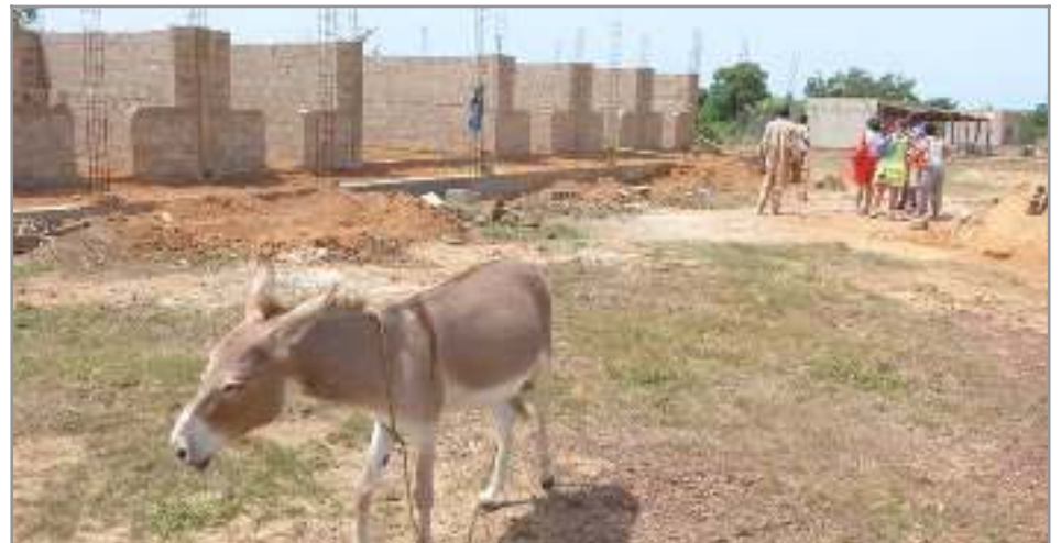
Les murs du dortoir de l'internat commencent à sortir de terre.
